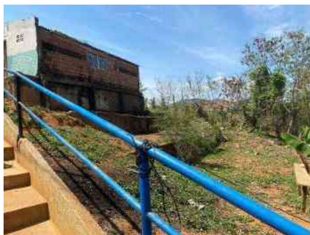
Figura 4 Área indicada ao lado da igreja o.
